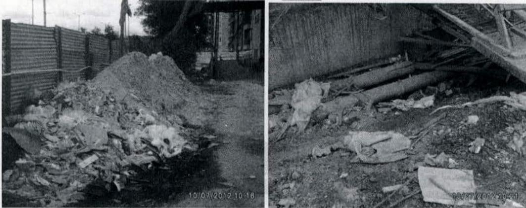
**Foto 10 y 11.** Manejo inadecuado de residuos sólidos mezclados con escombros y residuos especiales y residuos dispersos por la obra.
