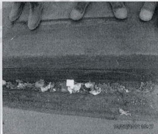
**Foto 3 y 4.** Falta protección con rejilla en el cárcamo y limpieza en sumideros
